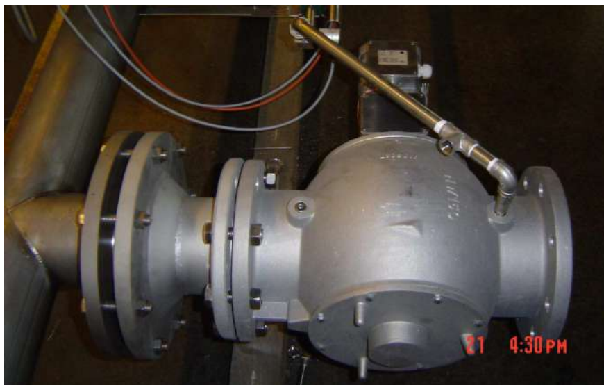
Fig. 9. Dispositif arrête-flamme et vanne de gaz principale
