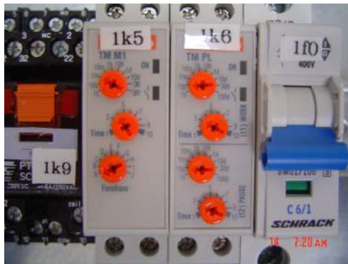
Fig. 12. Relais temporisé 1k5 et 1k6
