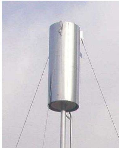
Fig. 6. Haubanage au niveau de la tête de la torche
